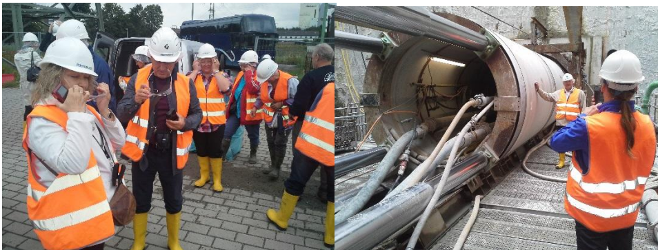
Emscherumbau life – nach den Sicherheitsbelehrungen ging es mit Helm und Weste bekleidet in den Vortriebsschacht in Recklinghausen-Süd
