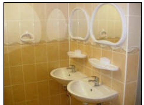
Einer der bereits renovierten Waschräume
